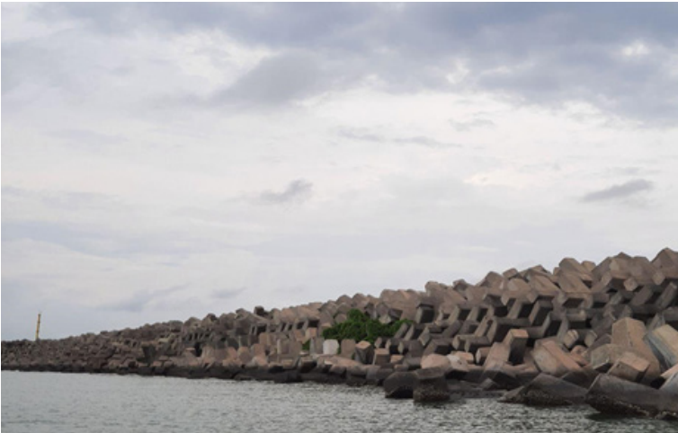
Gambar 1. Pemecah Gelombang PLTU Cilacap Tampak Dari Dekat
